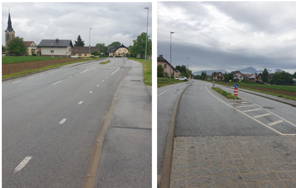
Sliki 30a in 30b: Cesta na Jami – obnovljeni odsek, smer Podreča in smer Orehek
