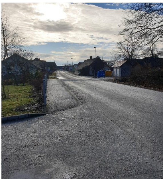
Slika 39: Cestna ovira in odsek pločnika na cesti v naselju Podreča, smer Ljubljana
